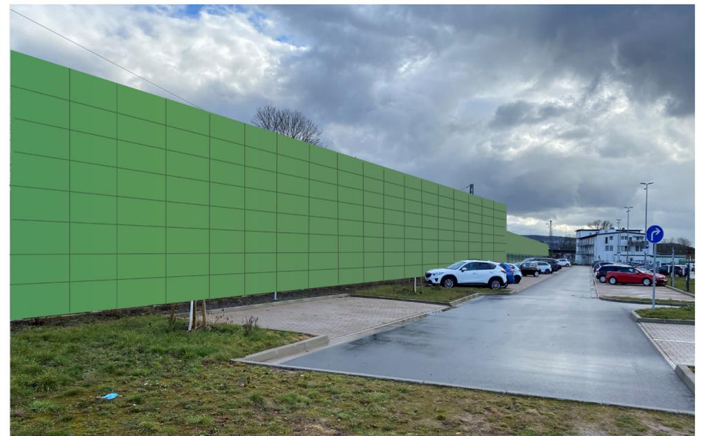
Abbildung 50: Projekte Variante mit vollflächiger Belegung (ohne Sichtfensterstreifen) am Beispiel der Lärmschutzwand entlang des P+R-Parkplatzes am Bahnhof Bad Hersfeld
