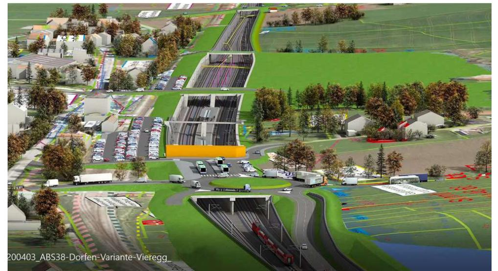
Abbildung 42: Beispiel der Stadt Dorfen: Tieferlegung der Bahnstrecke als sogenannter Bahntrog von Verkehrsplaner Martin Vieregge für einen Ausbau ohne Mauern und Schranken.
