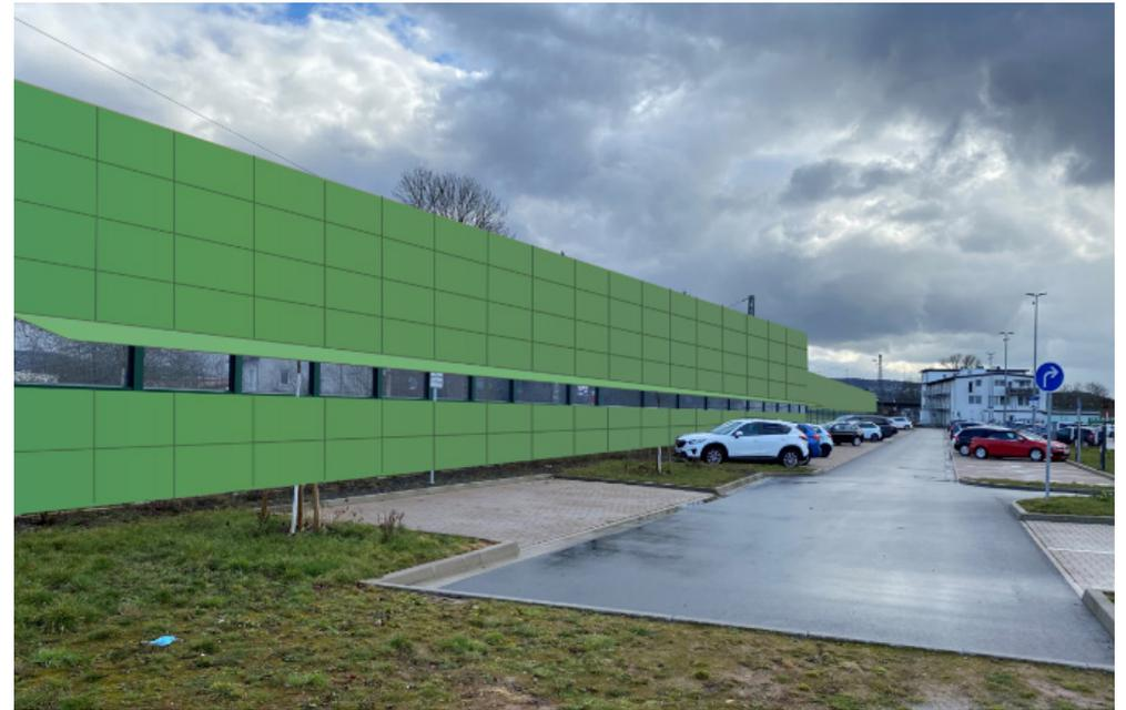
Abbildung 49: Projekte Varianten mit Sichtfensterstreifen am Beispiel der Lärmschutzwand entlang des P+R-Parkplatzes am Bahnhof Bad Hersfeld
