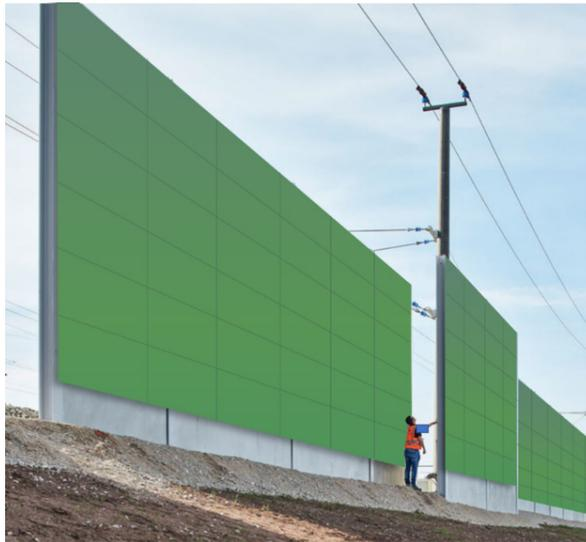
Abbildung 47: Die in Abbildung 46 dargestellte Lärmschutzwand mit davor gesetzten senkrechten eingefärbten PV-Modulen.
