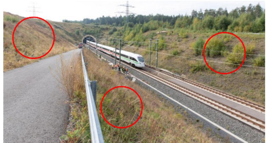
Abbildung 42: Markierte Anwendungsflächen für blendfreie PV-Module in Böschungsbereichen.
