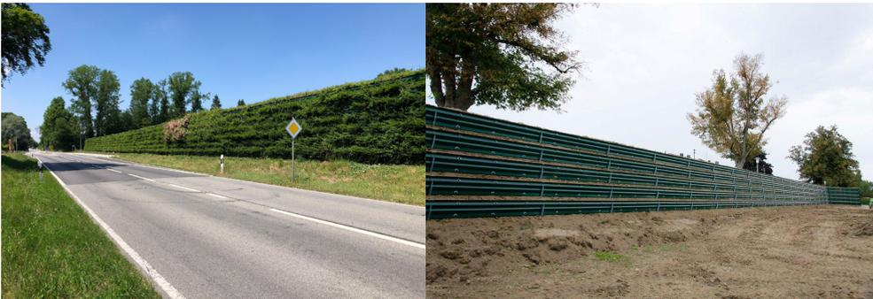
Abbildung 39-40: Bepflanzte Lärmschutzwände (Naturawall GmbH, Frasdorf, 2021)
