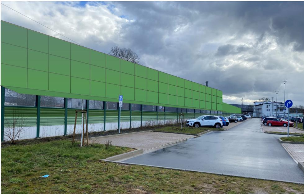
Abbildung 48: Projekte Varianten mit Sichtfensterstreifen am Beispiel der Lärmschutzwand entlang des P+R-Parkplatzes am Bahnhof Bad Hersfeld
