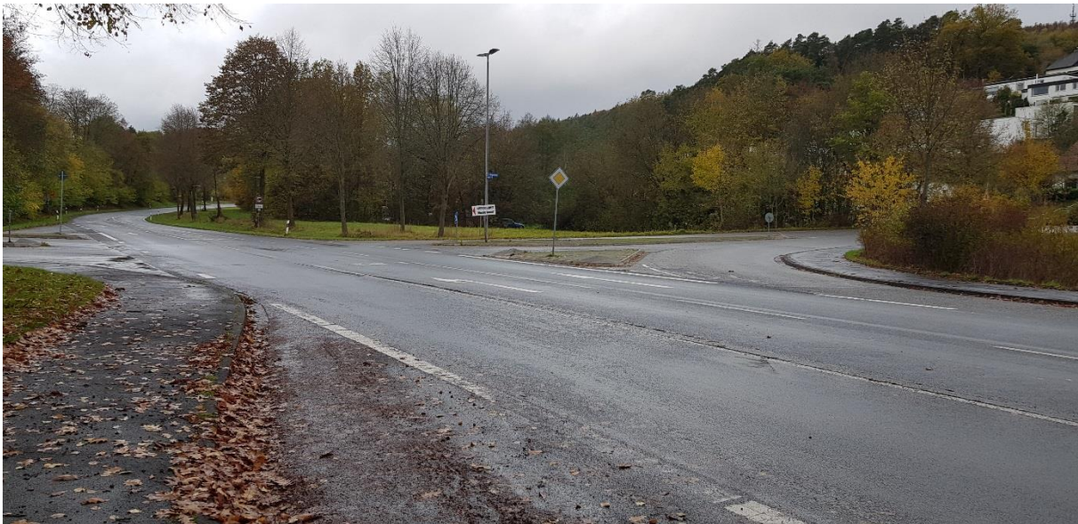
Bild 5: Knotenpunkt Meisebacher Straße/Mönchesweg/Am Lax, Blick in Richtung stadtauswärts, Stationsbereich 1 + 270 bis 1 + 320 auf Höhe der Busbucht. Links die Einmündung der Straße Am Lax, rechts die Einmündung des Mönchesweges.
