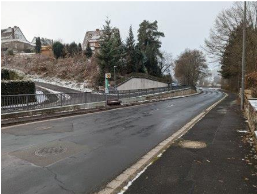
Bild 2: Bushaltestelle Schlipptal bei Stat. 0 + 805 (nicht barrierefrei), Blick in Richtung stadtauswärts. Im Hintergrund die Alte Meisebacher Straße.
