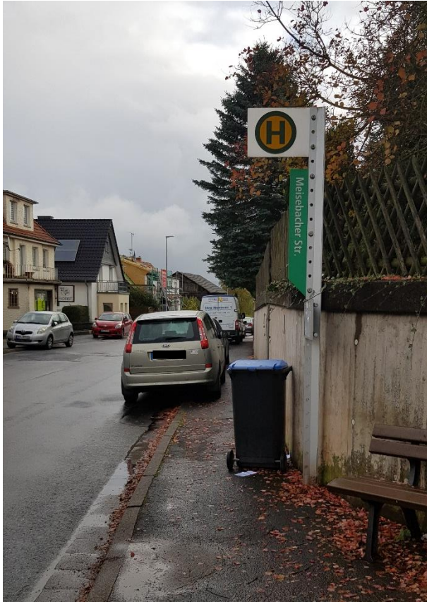
Bild 1: Bushaltestelle Meisebacher Straße bei Stat. 0 + 590 (nicht barrierefrei), Pkw beparken den 1,50 m breiten Gehwegbereich. Blick in Richtung stadteinwärts.
