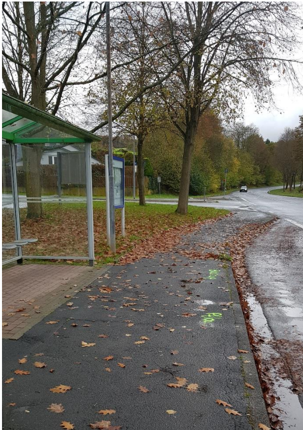
Bild 3: Bushaltestelle bei Stat. 1 + 255 (nicht barrierefrei), Blick in Richtung stadtauswärts. Im Hintergrund die Einmündung der Straße Am Lax, rechts am Bildrand die Meisebacher Straße.
