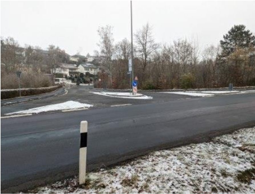
Bild 6: Knotenpunkt Meisebacher Straße/An der Sommerseite, Blick in Richtung An der Sommerseite, Aufnahme bei Stationsbereich 0 + 985.
