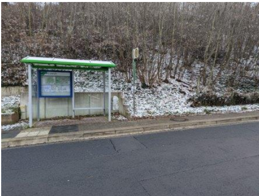
Bild 4: Bushaltestelle Eisteich unterhalb des Bauanfanges. Nur eingeschränkte Barrierefreiheit vorhanden.
