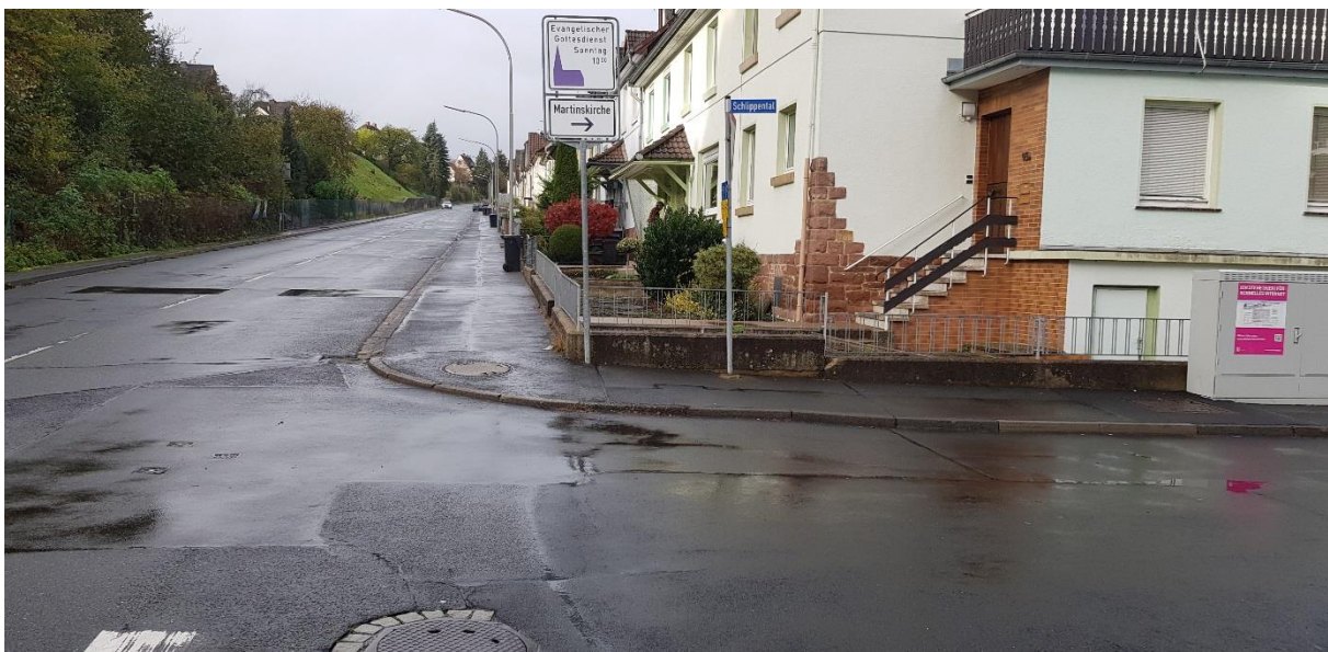
Bild 8: Einmündungsbereich Schlipptal (Stat. 0 + 130), Blick in Richtung stadtauswärts
